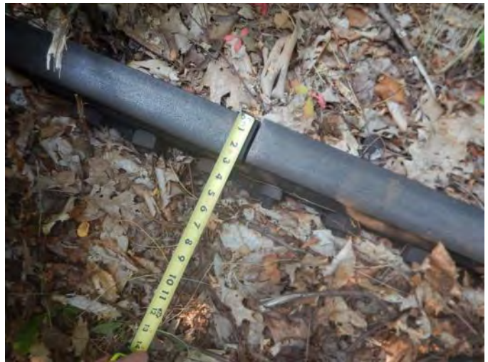
4.22 Rail End Mismatch (§213.115)
